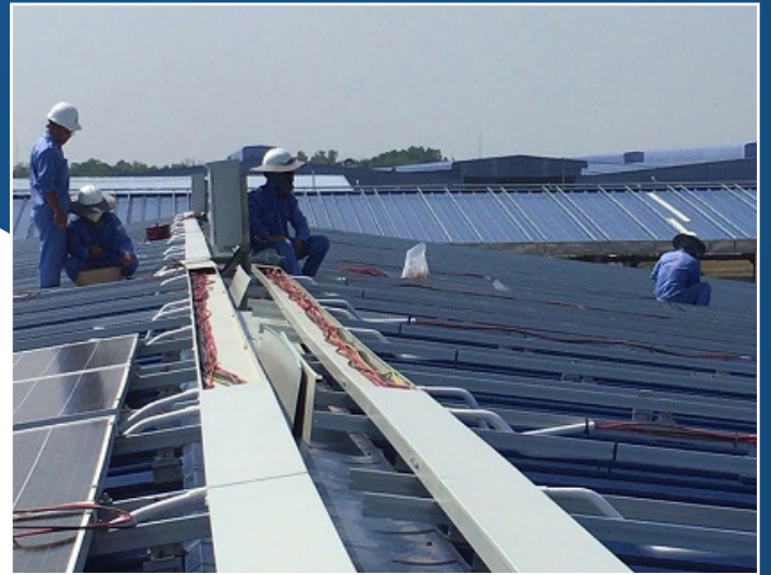
Máng cáp thi công lắp đặt trong hệ thống điện năng lượng mặt trời
