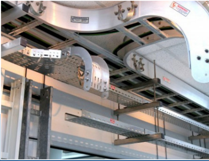
Thang máng cáp trong thi công hệ thống cơ điện
