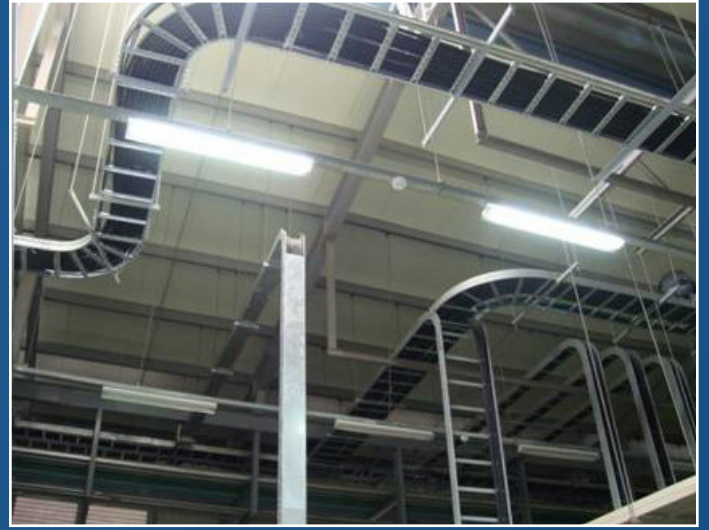
Thang máng cáp trong thi công hệ thống cơ điện
